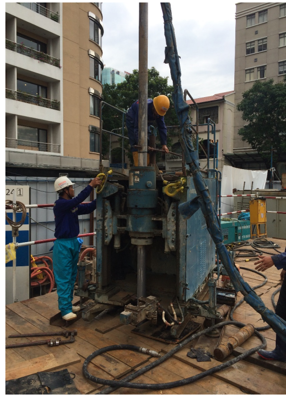
Hình 5. Thiết bị jet - grouting tại tuyến hầm Metro số 1 TP. Hồ Chí Minh.
